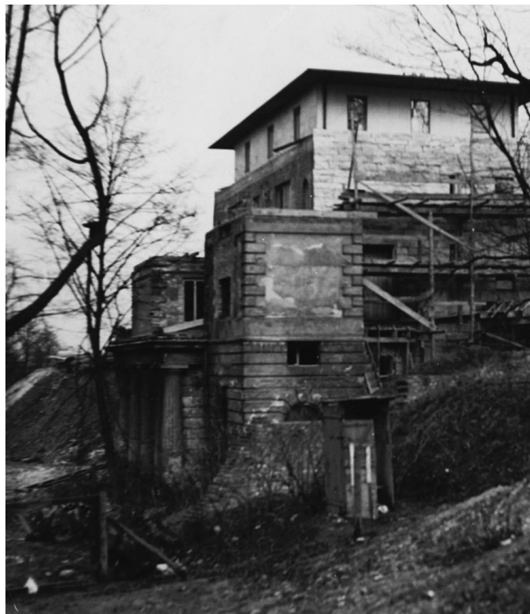
Przebudowa „łóży masonskiej”, czyli willi Pniewskiego, NAC
