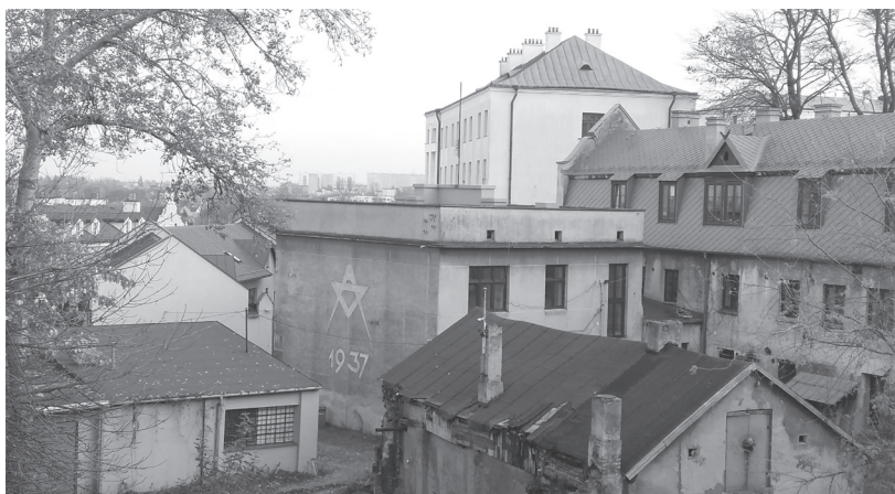
Widok z ul. Wyszyńskiego na dwór należący od 1923 roku do Wandy i Franciszka Papiewskich wraz z oficyną mieszkalną i „reklamą” firmy budowlanej Papiewskiego „Architekt”. Fot. Klaudia Olender
