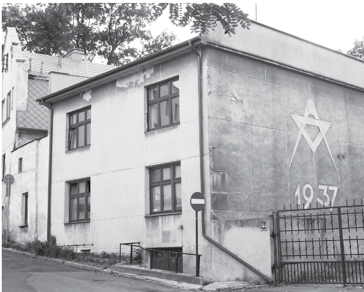
Dom Papiewskich z dobudowaną od strony ul. Misjonarskiej oficyną. Mieścił od lat 40. m.in. biura i magazyn LSS. Fot. autorki
